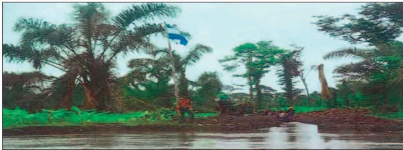
Three images showing the construction of the canal. The Nicaraguan flag is visible on the bank of the canal. Trois photographies montrant le creusement du canal. Le drapeau nicaraguayen est visible sur la rive du canal.
