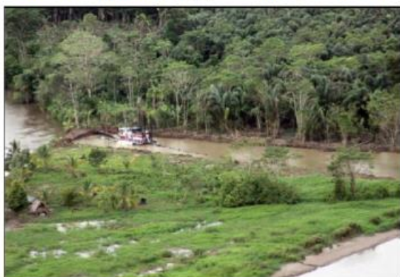
e) 29 janvier 2011 : drague sur le point de terminer ses travaux
