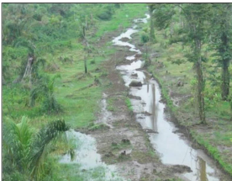
Figure I.35 : Remblais générés par l'excavation du sol creusé en vue de créer le caño . Photographie réalisée le 5 avril 2011.
