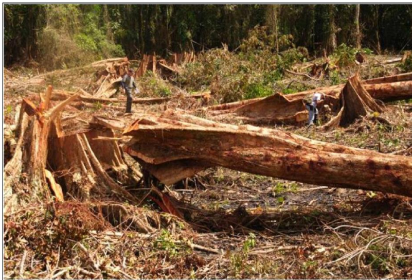
a) Taille des arbres abattus pour nettoyer la forêt et dégager un espace pour la construction du caño
