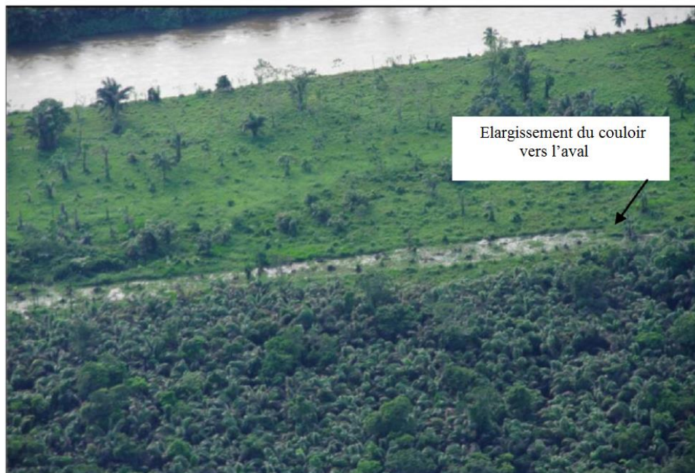
Figure I.26 : Le 1 er novembre 2010, le couloir nettoyé en vue de la construction du caño était en cours d'élargissement, même si les travaux n'englobaient pas l'intégralité dudit couloir en direction de l'aval
