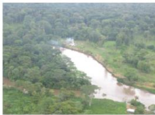
h) Erosion localisée de la rive à l'extrémité d'une portion divisée
