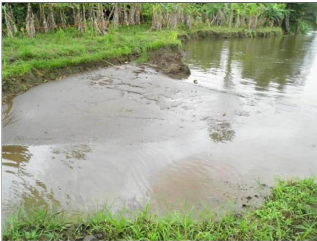
Figure I.41 : Banc de sable bloquant partiellement l’embouchure du Carlo. Photographie prise le 5 avril 2011.
