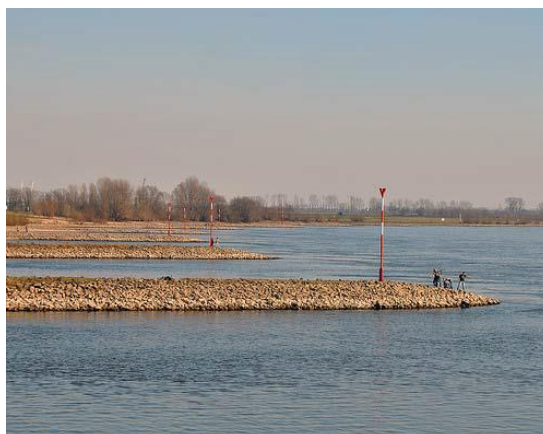
Figure 3 : Exemple caractéristique d'un cours d'eau coulant sur des terres basses (le Waal) sur lequel des épis ont été installés.
