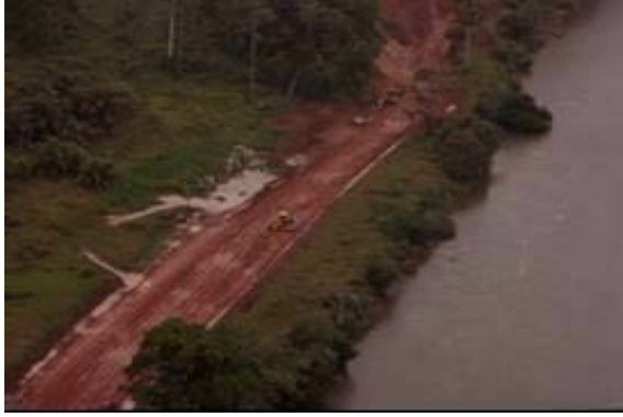
Figure 29 : accroissement des sédiments dû à l'effet barrière sur de petits cours d'eau
