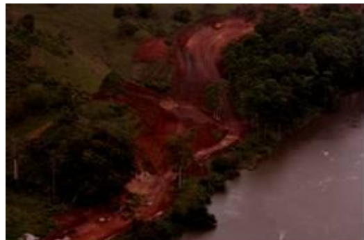
Figure 36 : point critique dû à l'instabilité géologique
