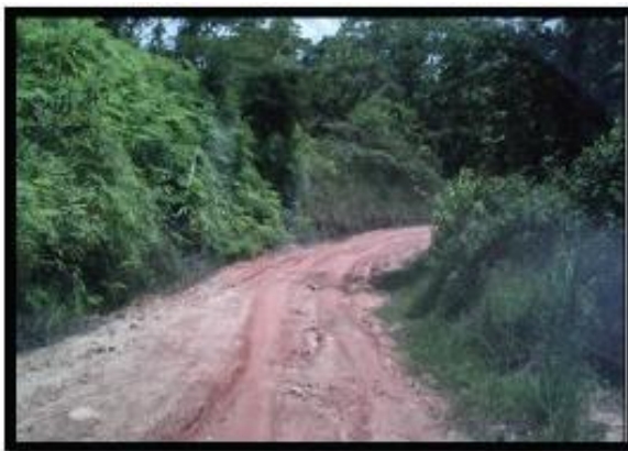
F24. Zones parsemées de trous et fissures, dépourvues de système de drainage
