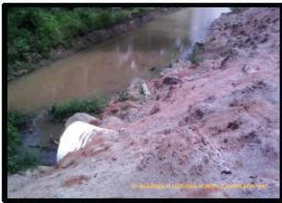
F41. Conduit circulaire utilisé comme évacuation pour les eaux du fleuve F42. Portion de la route assez large pour un seul véhicule
