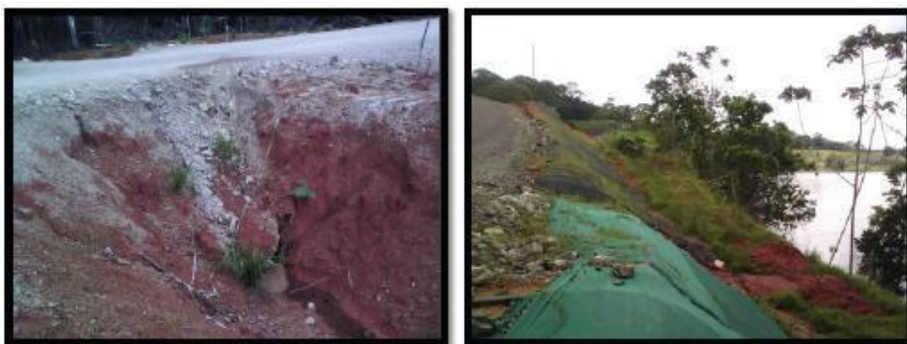
F32. Des rondins de bois sont utilisés pour permettre le drainage des eaux.
