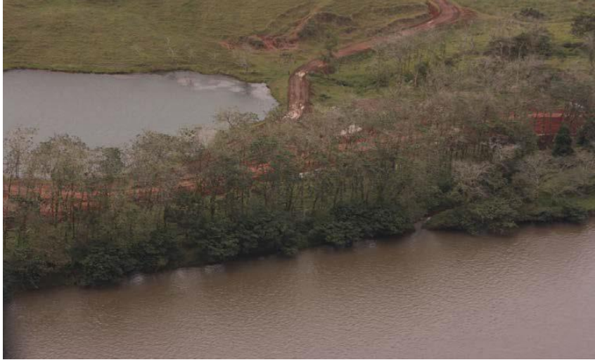
Figure 51 : effet barrière provoqué par la route entre des zones humides et le fleuve San Juan Source : FUNDENIC, 2012
