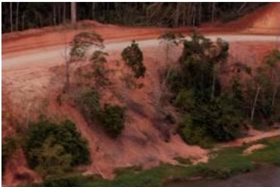
Figure 23 : glissement de pente et érosion du sol sur la berge du fleuve
