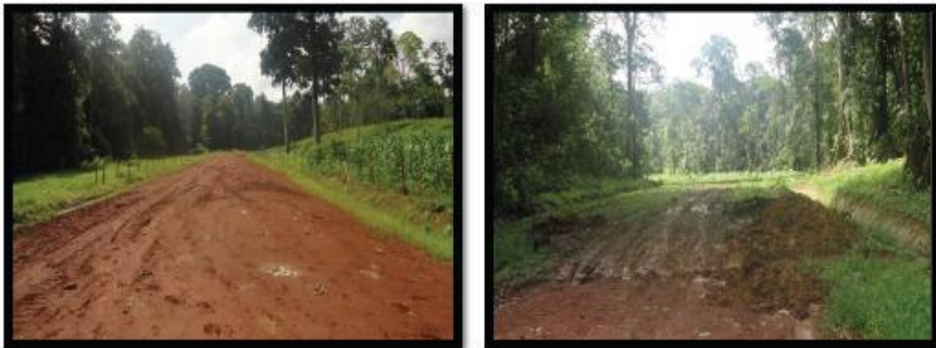
F11. Chemins en terre compactée.
