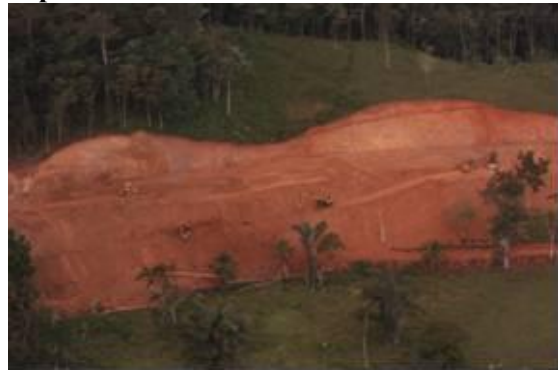
Figure 50 : point critique dû à l'instabilité de la pente
