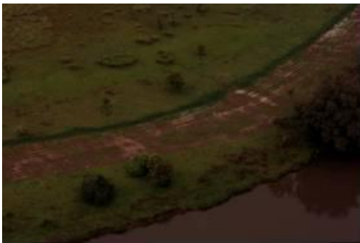
Figure 35 : point critique dû au risque d'inondation de la route le long du fleuve San Juan
