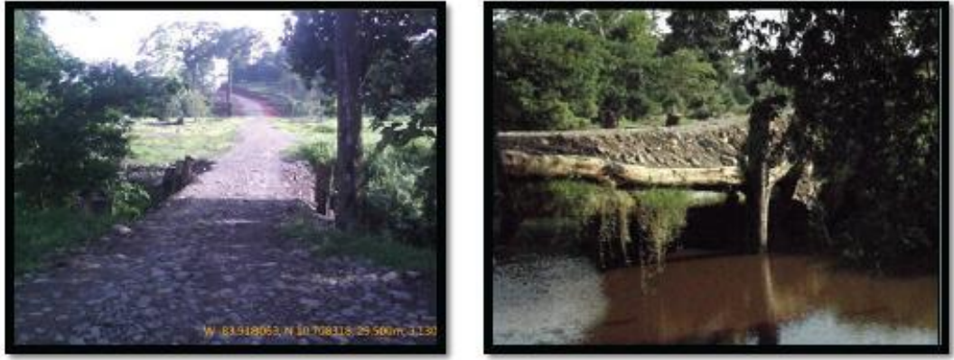
F5. Pont dont la base est construite en rondins de bois
