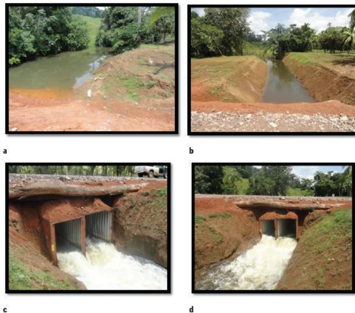
F17. Sur la première photographie a) , l'obstruction de l'écoulement naturel du fleuve est évidente. La deuxième photographie b) montre la construction d'un canal destiné à détourner le cours du fleuve. Les deux dernières photographies ( c) et d) ) montrent la construction d'un pont, dont la structure est notamment composée de rondins de bois et de deux conteneurs de transport utilisés pour le drainage ; son gonflement est visible, tout comme le gonflement des parois des conteneurs de transport.
