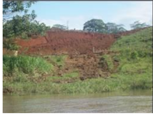
Figure 14 : section transversale d'un talus présentant une pente inadéquate Source : mission technique
