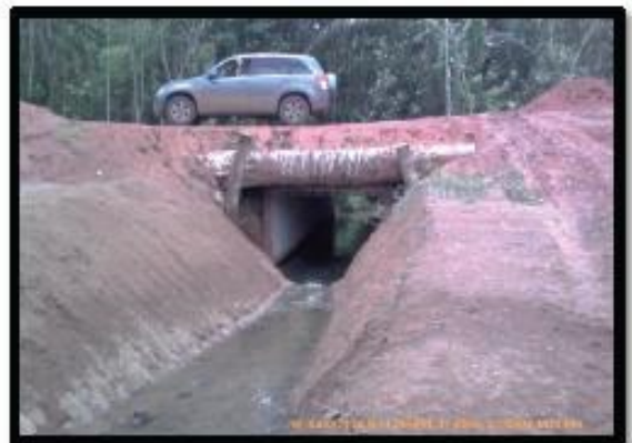
F41. Conduit circulaire utilisé comme évacuation pour les eaux du fleuve F42. Portion de la route assez large pour un seul véhicule
