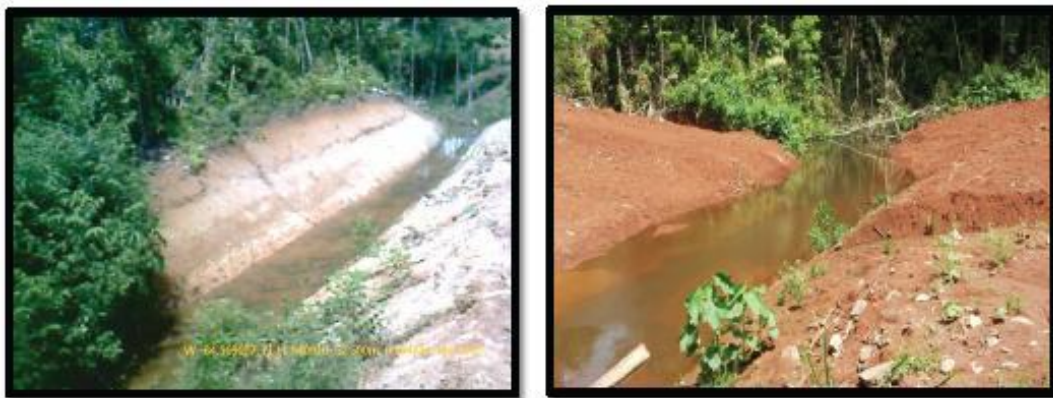
F52. Fossé de drainage en terre servant d'évacuation d'eau
