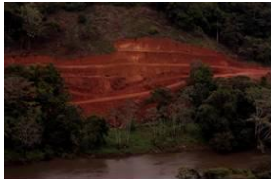
Figure 48 : point critique dû à l'instabilité de la pente
