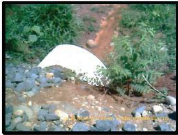
F46. Conduits circulaires servant d'évacuation pour les eaux du fleuve F47. Conteneur de transport utilisé comme pont
