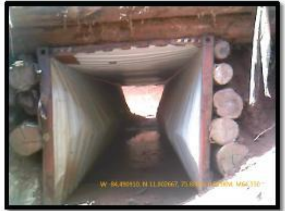
F46. Conduits circulaires servant d'évacuation pour les eaux du fleuve F47. Conteneur de transport utilisé comme pont
