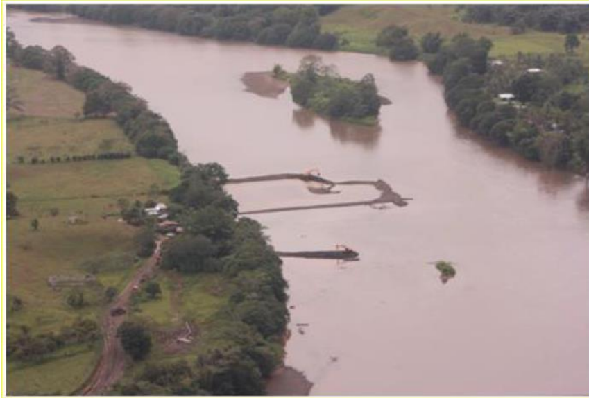
Figure 4 : remblais pour la construction d'un pont sur le fleuve San Carlos
