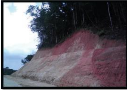
F28. Dans cette zone se dressent d'immenses talus, aux crêtes très élevées, sans aucune protection.
