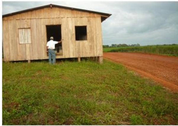
Figure 12 : habitation en bordure de la pente de la route
