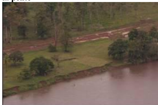
Figure 44 : point critique dû à l'érosion du bord du chenal, sur la rive droite du fleuve, accélérée par la construction de la route
