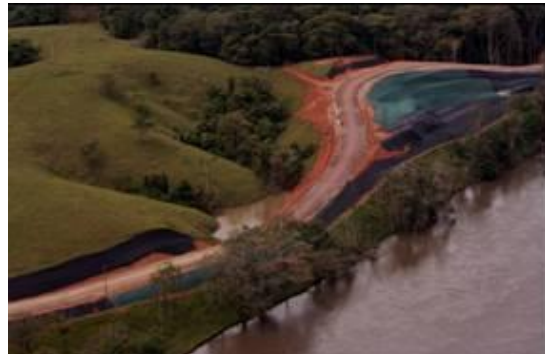
Figure 40 : point critique dû à l'instabilité de la pente
