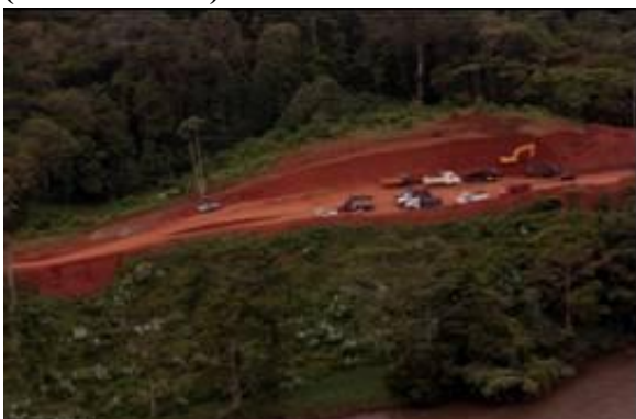
Figure 27 : la concentration d'équipements accroît les niveaux de pollution atmosphérique et sonore
