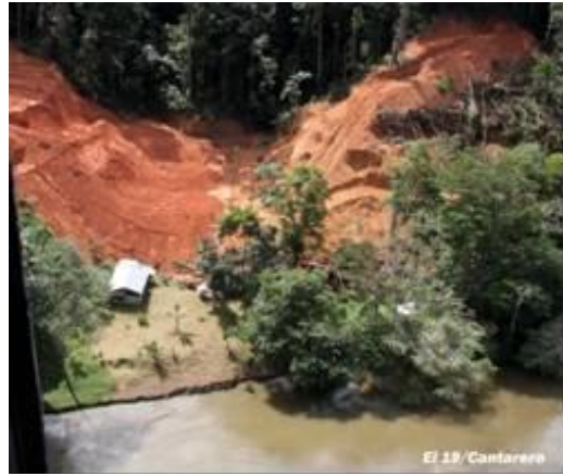
Figure 32 : point critique dû au risque de diminution du débit du fleuve San Juan
