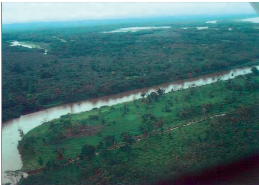
Construction of the canal. Creusement du canal.
