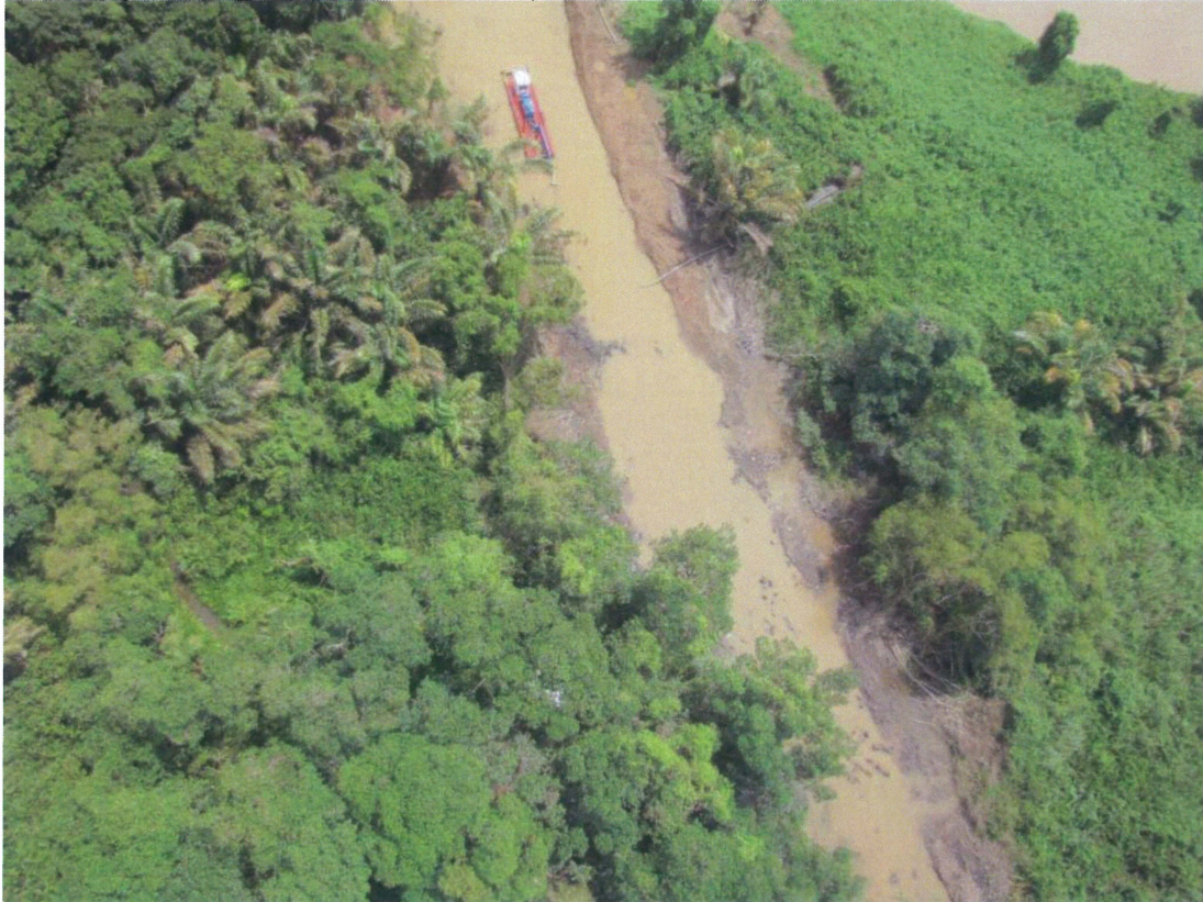
Foto 2. Vista parcial del nuevo canal artificial. Nótese la draga en medio del canal. En el extremo superior derecho se observa una sección del río San Juan.
