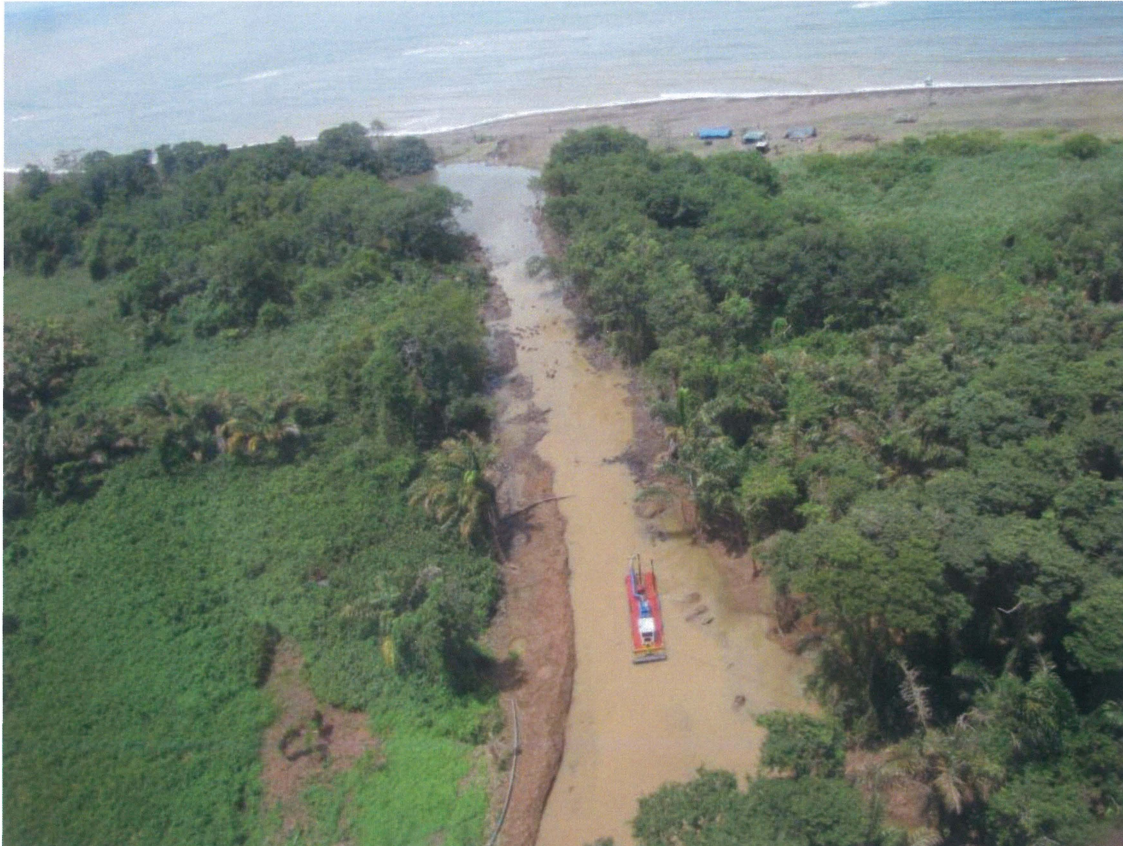
Foto 5. Vista parcial del canal artificial en sentido sur-norte. Se puede observar en la parte superior tanto la laguna como el campamento.
