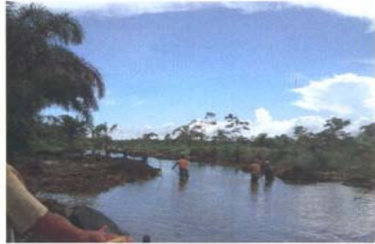
Trabajos de limpieza manual
