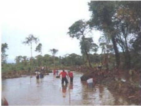
Trabajos de limpieza manual
