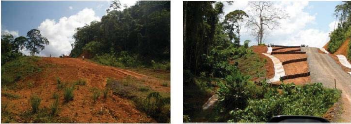
Figure 43. Route au point de coordonnées 502480 de latitude est et 321561 de longitude nord, à proximité de l’Infiernito a) le 15 février, où le ruissellement de surface non contrôlé provenant de la plate-forme de la route et des talus voisins déstabilisés pendant la construction avait causé une érosion en nappe et en rigoles dans les zones de sol nu, et b) le même tronçon le 7 mai 2013, après la pose d’une couche de pierre concassée pour protéger la surface de la route, l’installation de clôtures pour prévenir l’érosion en nappe et en rigoles, et la construction de rigoles extérieures et intérieures bétonnées pour diriger vers le bas de la pente les eaux de ruissellement de surface. Photographies prises par l’auteur.
