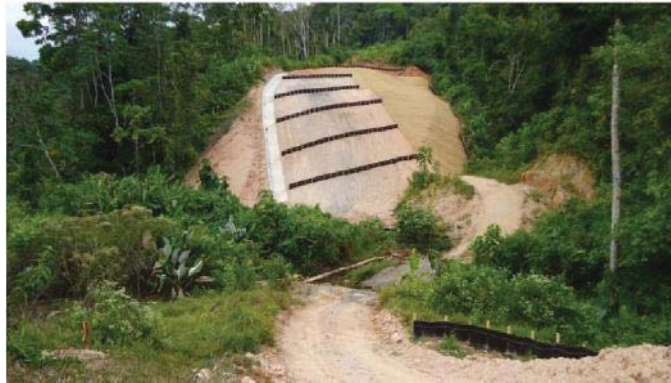
Photo 1. Création de talus, pose de la fibre de coco, construction de fossés et pose d'une clôture anti-érosion
