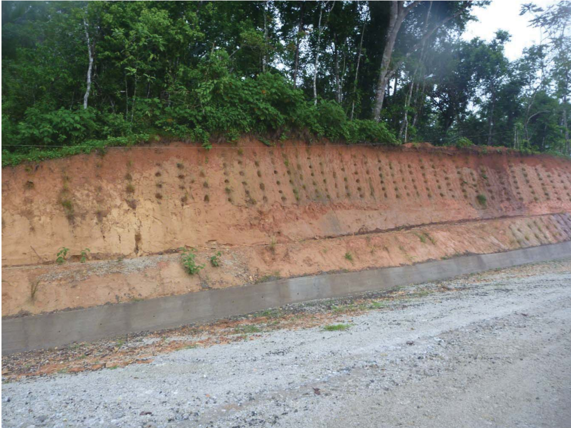
Figure 11. Portion de la zone s'écoulant dans le piège à sédiments n° 2.
