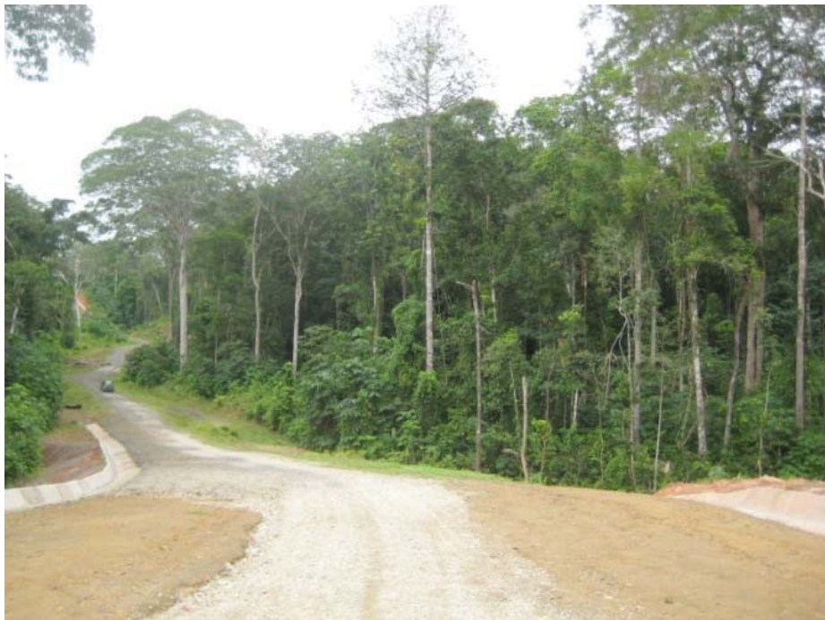
Fossés creusés afin de canaliser les eaux de ruissellement.
