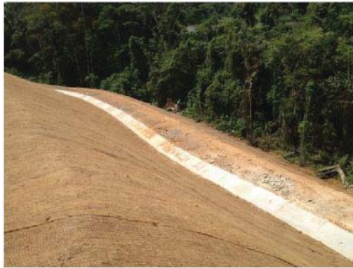
Photo 11. Création de talus, pose de la fibre de coco, construction de fossés et pose d'une clôture anti-érosion
