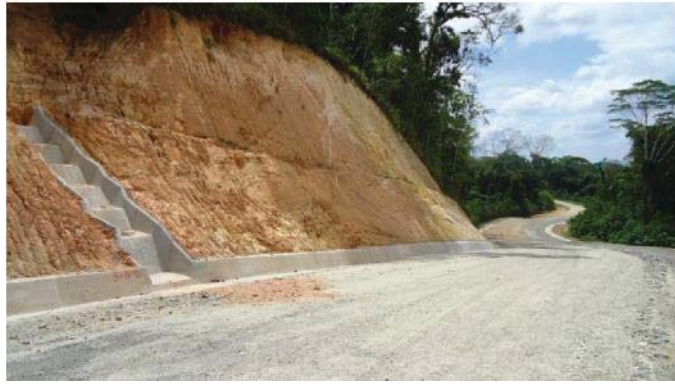
Photo 4. Construction de dissipateurs
