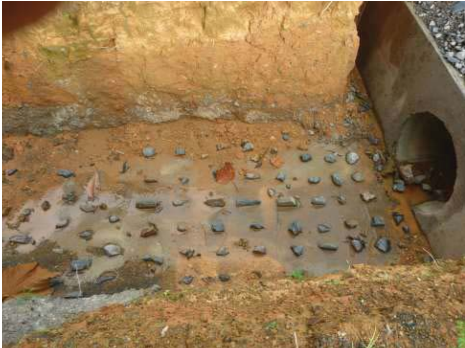
Installation de tuyaux en ciment au niveau des petits écoulements.
