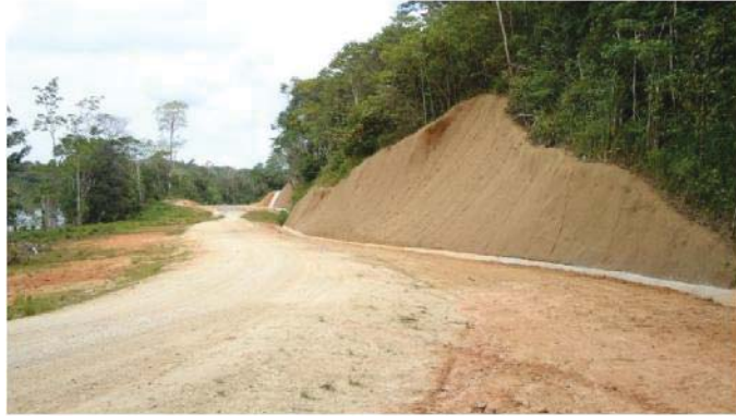
Photo 7. Pose de la fibre de coco, construction de fossés
