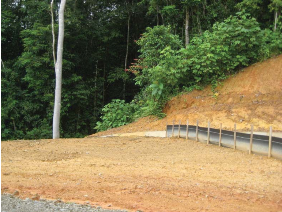
Barrières de protection visant à prévenir le ruissellement.
