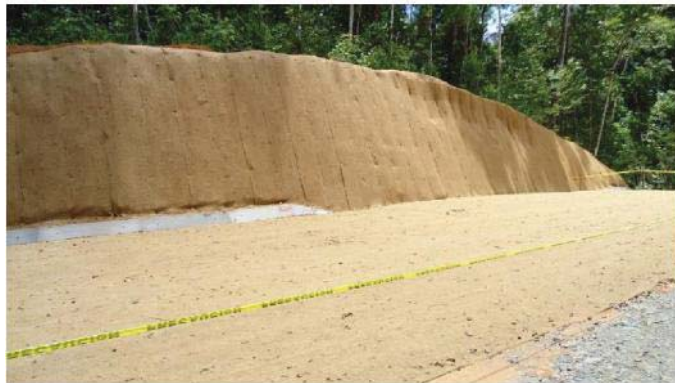
Photo 9. Pose de la fibre de coco, construction de fossés
