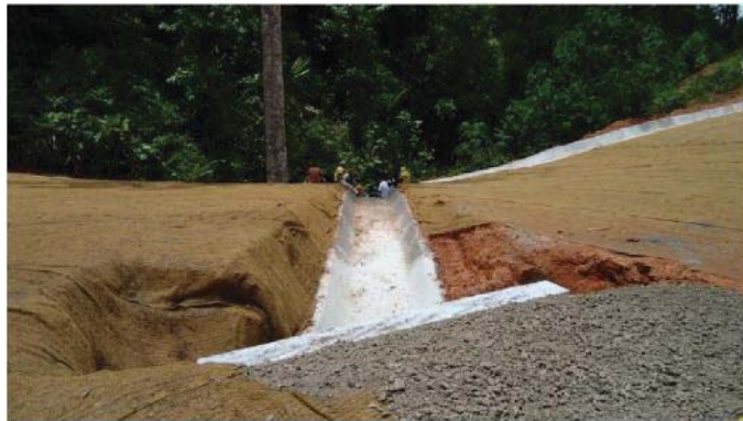
Photo 8. Construction de chenaux revêtus, pose de la fibre de coco et construction de fossés
