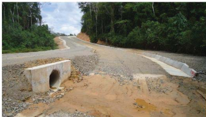
Photo 6. Pose de tuyaux, construction de parois, construction de fossés
