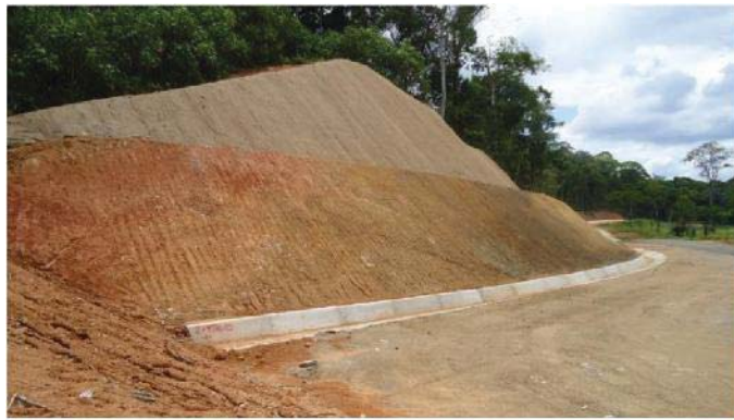
Photo 5. Création de talus, construction de fossés et de fossés de crête
