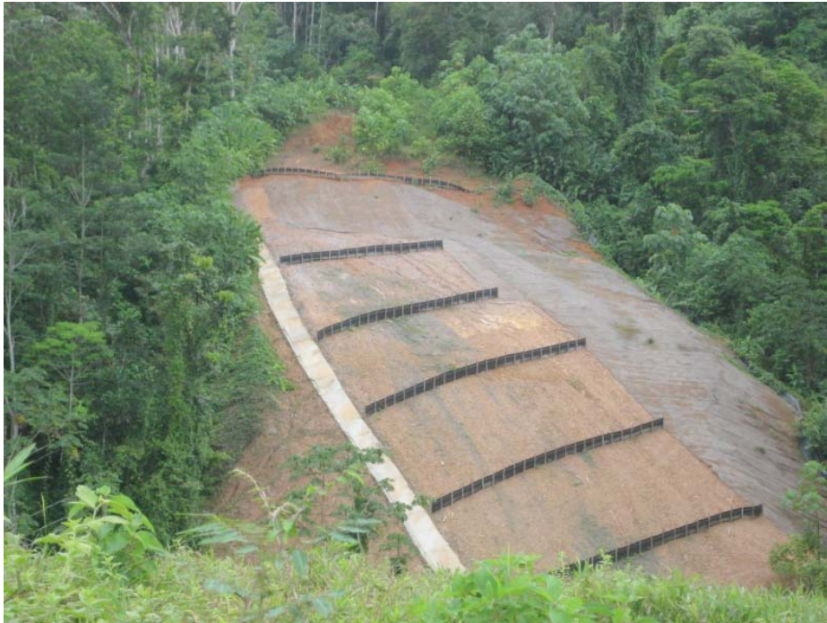
Installation d'une clôture antiérosion sur les talus.
