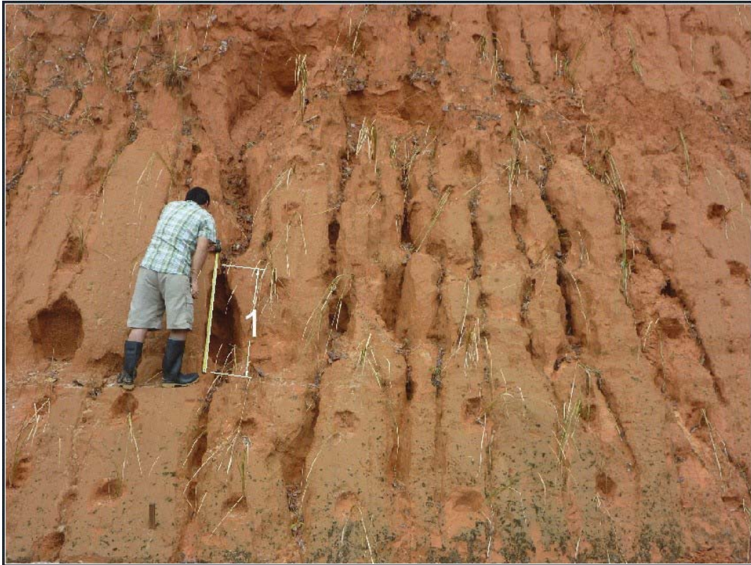
Figure 3. Talus de déblai présentant une érosion en rigoles et un mètre de ruban de mesure pour marquer l'échelle.
