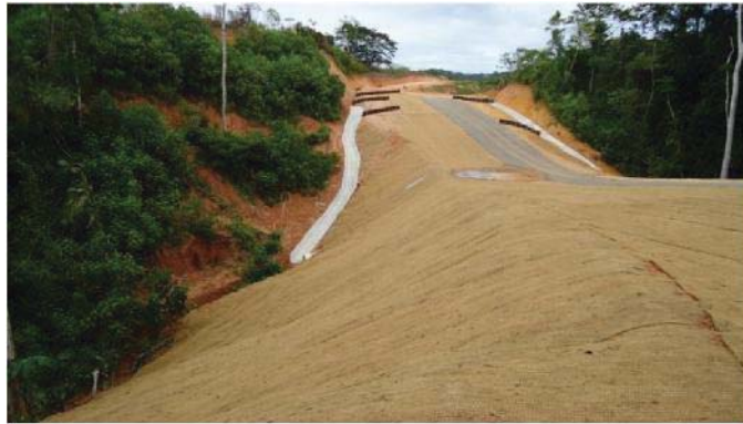
Photo 2. Création de talus, pose de la fibre de coco, construction de fossés et pose d'une clôture anti-érosion
