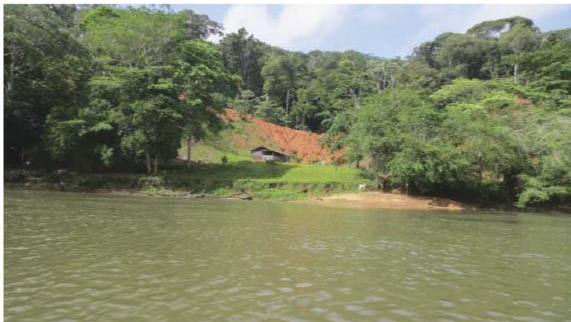
Photo 2 : Emplacement : KM 18,2 à 18,3 de la route (depuis le bateau, mai 2014). Formation d'un delta alluvionnaire causé par l'effondrement d'un passage de cours d'eau en remblai et par une érosion d'un autre type.
