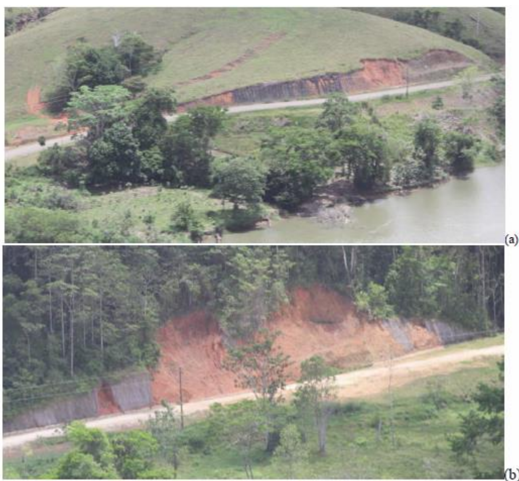
Figure 27 : Couche de matériau plastique de contrôle de l'érosion en voie de disparition à deux endroits situés approximativement à 6,8 km (pour la photographie (a)) et 10 km (pour la photographie (b)) en aval de la borne n° II.
