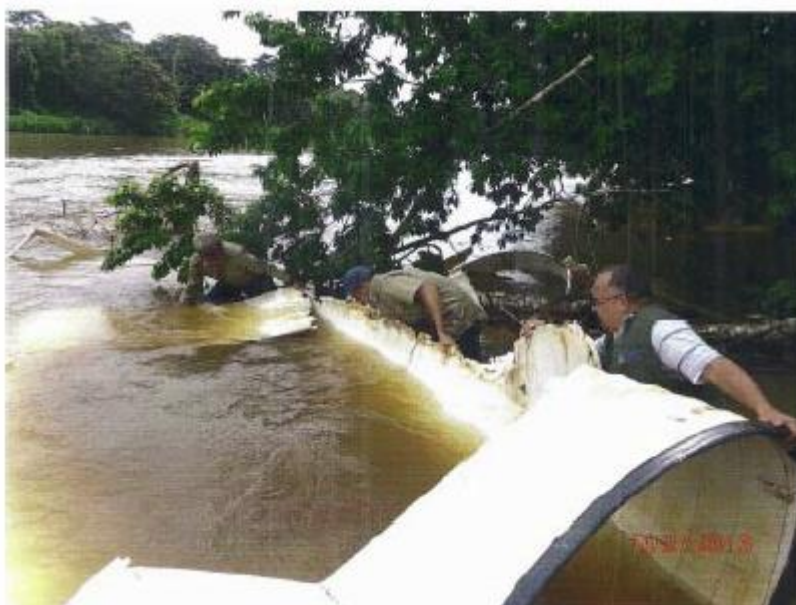
Figure 12 : Equipe nicaraguayenne travaillant dans le delta s'avançant dans le San Juan pour retirer un tuyau en plastique arraché au passage du cours d'eau au point d'érosion marquée n° 9.4. Date de la photo : 27 octobre 2013. Document communiqué par le Gouvernement nicaraguayen.
