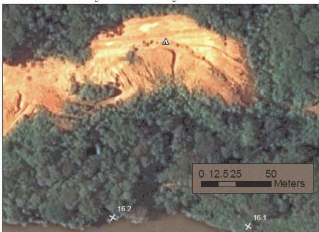
Figure 18 : Point d'érosion marquée n° 8.1, à 16,1 km en aval de la borne n° II. Image satellite à haute résolution de décembre 2013.
