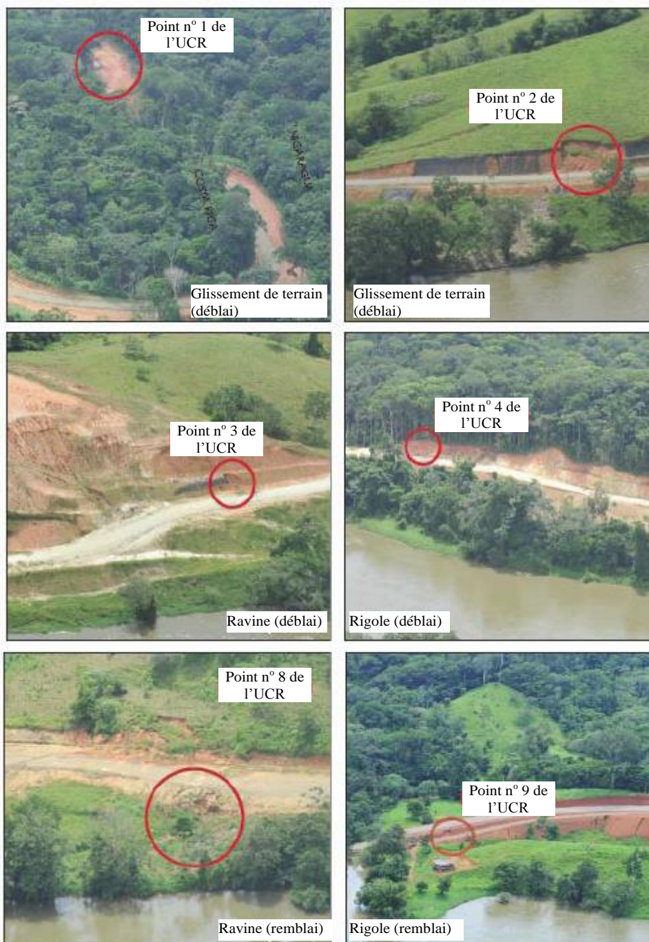
Figure 30 : Points étudiés par l'UCR et soumis à une érosion revêtant la forme de glissements de terrain, d'un ruissellement et d'un ravinement
