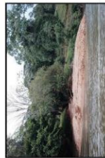
Delta sédimentaire créé par l'érosion des talus de remblai et de déblai (mars 2014)
