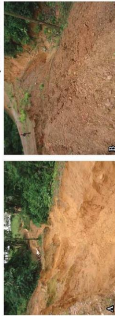
Ravine sur la face avant (A) et érosion sur la face arrière du prisme de remblai (B) (photographies extraites de la page 43 du rapport de 2013 de Mendé and Astorga)
