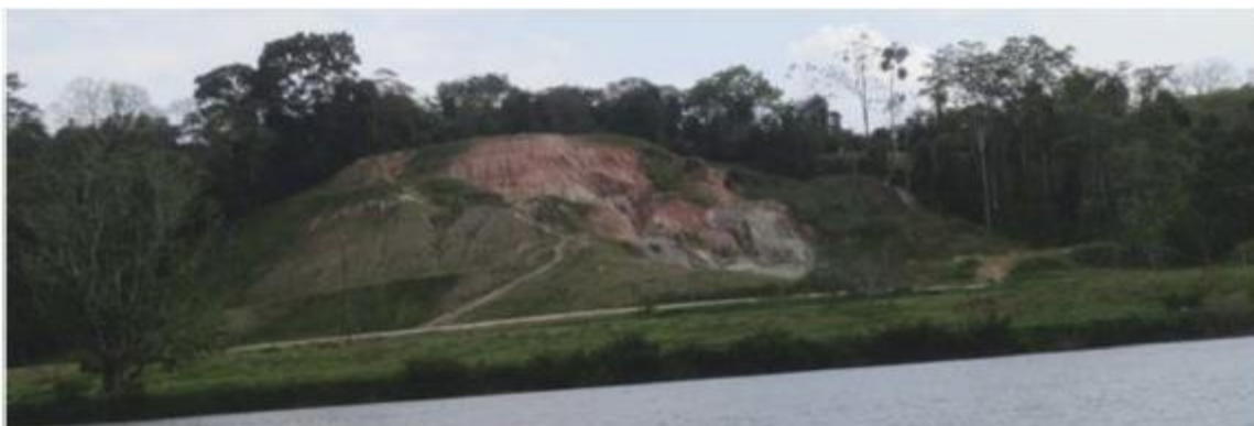
Photo 12 : Emplacement : KM 7,4 à 7,9 de la route (depuis le bateau, mai 2014). Sablière utilisée pour extraire des sols pour la construction de la plate-forme. La sablière construite en altitude est restée ouverte et soumise à l'érosion, causée par les précipitations, sans meilleures pratiques de gestion.
