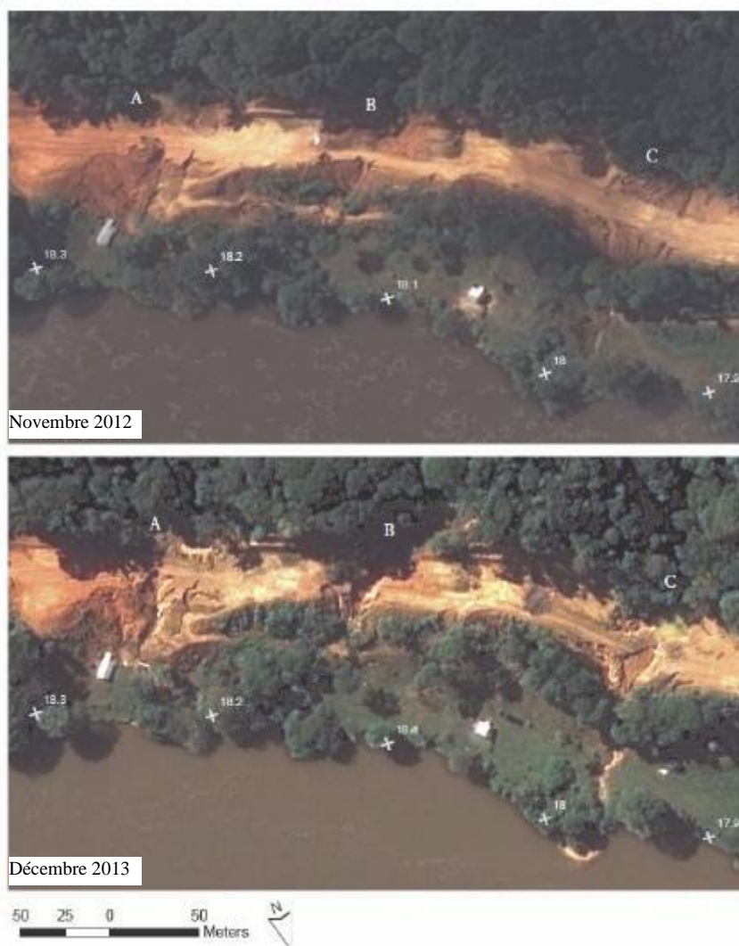
Figure 9 : Progression de l'érosion à Las Crucitas, au point situé entre les kilomètres 17,9 et 18,3 en aval de la borne n° II. A) Image satellite de novembre 2012 montrant que l'érosion a déjà commencé à attaquer les talus de remblai et les prismes des passages de cours d'eau. B) Image satellite de décembre 2013 montrant les progrès importants de l'érosion et l'aggravation du ravinement dans le prisme de passage de cours d'eau «A», ainsi que le balayage des passages «B» et «C».
