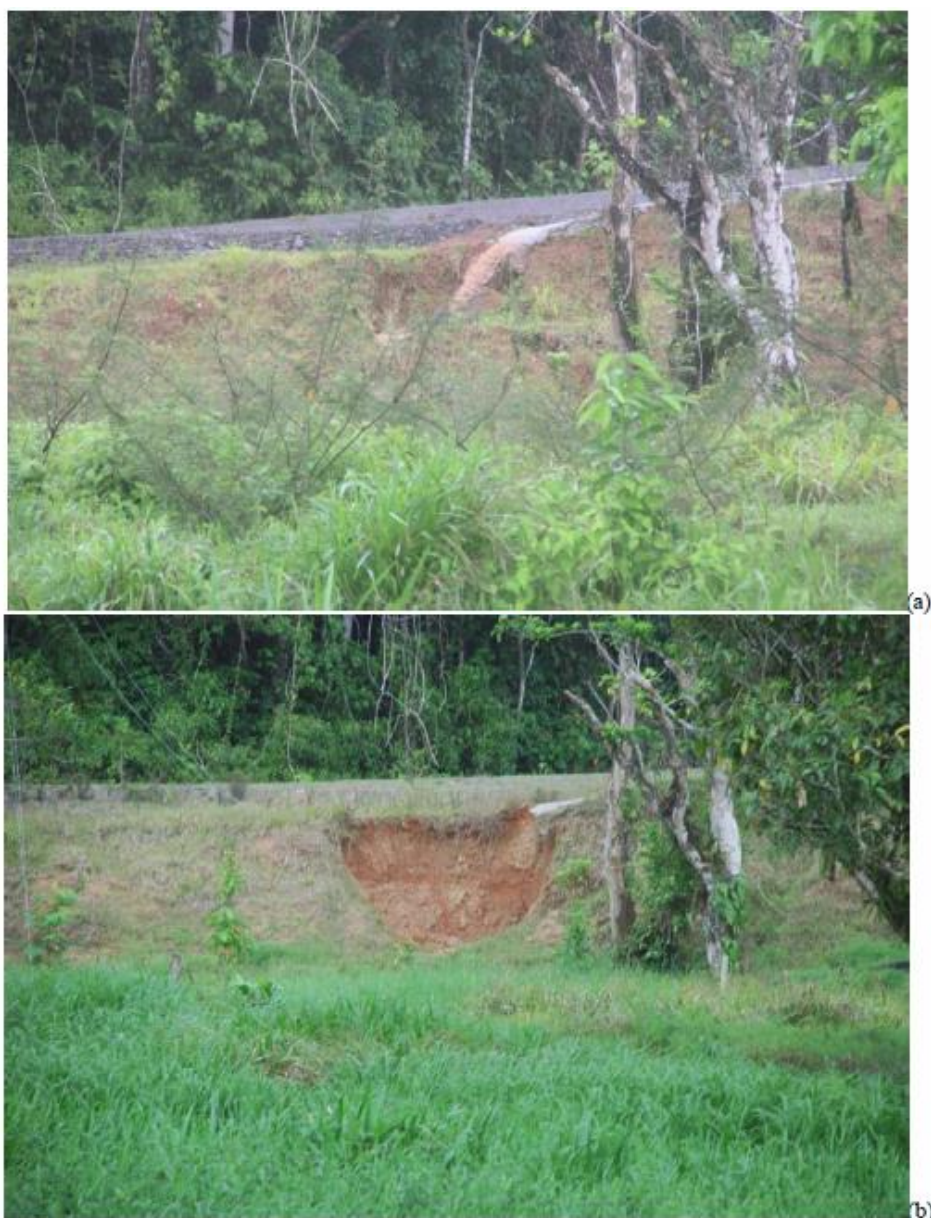
Figure 26 : Photographies montrant la manière dont les eaux de ruissellement de la route étaient évacuées au moyen d'une structure de drainage vers le talus de remblai en mai 2013 (a) et l'érosion résultante en mai 2014 (b)
