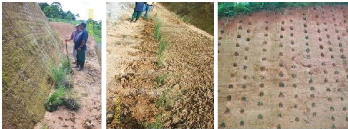
Figure 7.1 : Clichés illustrant les travaux de préparation et de plantation des talus entrepris par la CODEFORSA pour protéger la surface du sol le long de la route entre la borne n° II et Boca San Carlos
