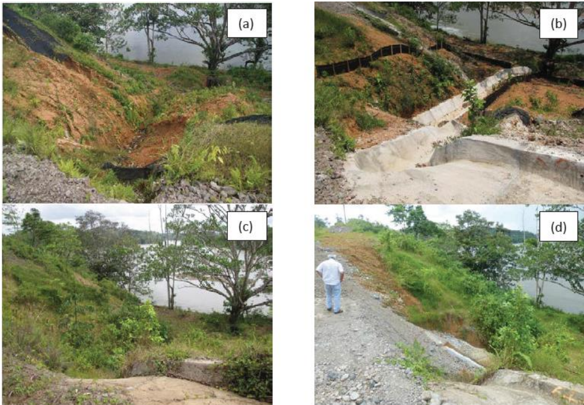
Figure 7.14 : Photographies de la route au point 49^{\circ} 80' 72'' de latitude est et 32^{\circ} 53' 45'' de longitude nord, à 6,6 km environ à l'est de la borne n° II a) le 15 février 2013, où l'on voit un réseau de ravines formé sur un talus extérieur et des dépôts de sédiments accumulés sur la surface plane d'une terrasse ; b) le 7 mai 2013, montrant les travaux d'atténuation réalisés (construction de canalisations bétonnées et de chutes, installation de clôtures anti-érosion et d'une trappe pour empêcher les sédiments d'atteindre le fleuve) ; c) en avril 2014, où l'on voit que l'érosion locale a cessé et que la végétation a été rétablie sur le talus ; d) en août, où le ponceau sous-dimensionné et le prisme de remblai sous-jacent à la route au niveau du passage du cours d'eau ont été remplacés par un ponceau plus important doté de structures d'entrée et de sortie, recouvert d'un mélange terre-ciment compacté. Photographies de l'auteur.
