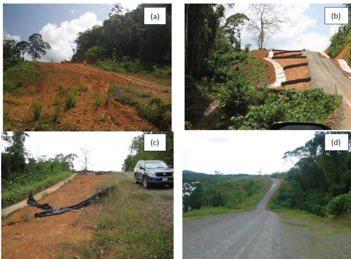
Figure 7.15 : Photographies de la route au point 50^{\circ} 24' 80'' de latitude est et 32^{\circ} 15' 61'' de longitude nord, près de l'Infiernito a) le 15 février, où les surfaces de sol nu présentait une érosion en nappe et des rigoles causées par le ruissellement de surface non contrôlé provenant de la plate-forme de la route et des talus voisins perturbés pendant la construction ; b) le même tronçon le 7 mai 2013, après la pose d'une couche de pierres concassées pour protéger la surface de la route, et l'installation de clôtures destinées à prévenir l'érosion en nappe et les rigoles et à évacuer le ruissellement de surface vers le bas de la pente au moyen de fossés bétonnés, intérieurs et extérieurs ; c) en avril, où les clôtures montraient des signes d'usure, mais la végétation se développait rapidement, et d) en août, où l'on voit que les mesures d'atténuation de l'érosion ont été efficaces dans ce secteur. Photographies de l'auteur.
