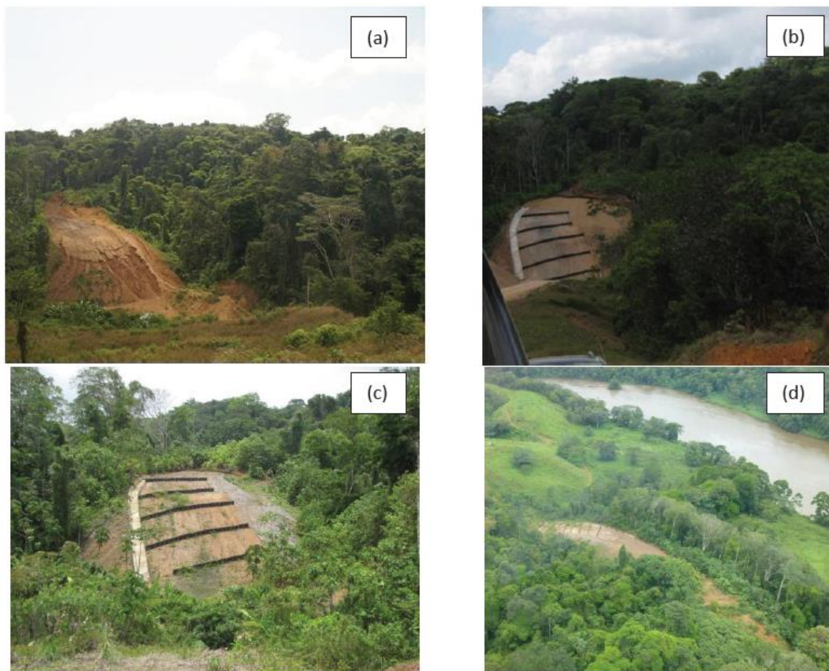
Figure 7.16 : Chemin défriché en vue de la construction de la route près de Crucitas, juste à l'est de l'Infiernito a) le 15 février, où le ruissellement non contrôlé provenant de ce chemin défriché avait causé une érosion en nappe et en rigoles ; b) le 7 mai 2013, après la mise en œuvre de mesures intégrées pour maîtriser le ruissellement, notamment des travaux de déblai et de remblai, l'installation de clôtures anti-érosion et la construction d'un fossé extérieur bétonné ; c) en avril 2014, où aucun changement important n'a été observé et d) en août 2014, où il était manifeste que les mesures d'atténuation de l'érosion continuaient d'être efficaces, et que cette zone ne produisait pas de sédiment atteignant le fleuve San Juan. Photographies de l'auteur.
