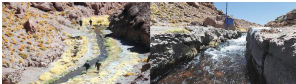
Canalisation artificielle créée pour capter les eaux du Silala
