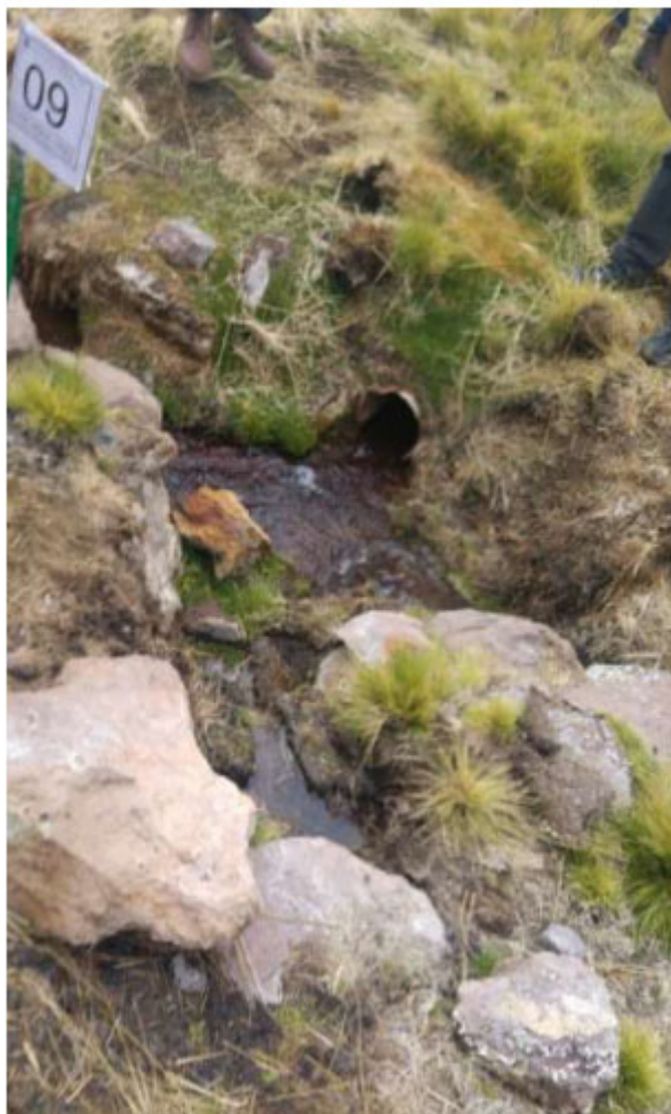
Figure 18. Conduite de drainage adjacente à une source de Silala qui jaillit de la formation rocheuse (source : annexe C, dans DHI, rapport final)
