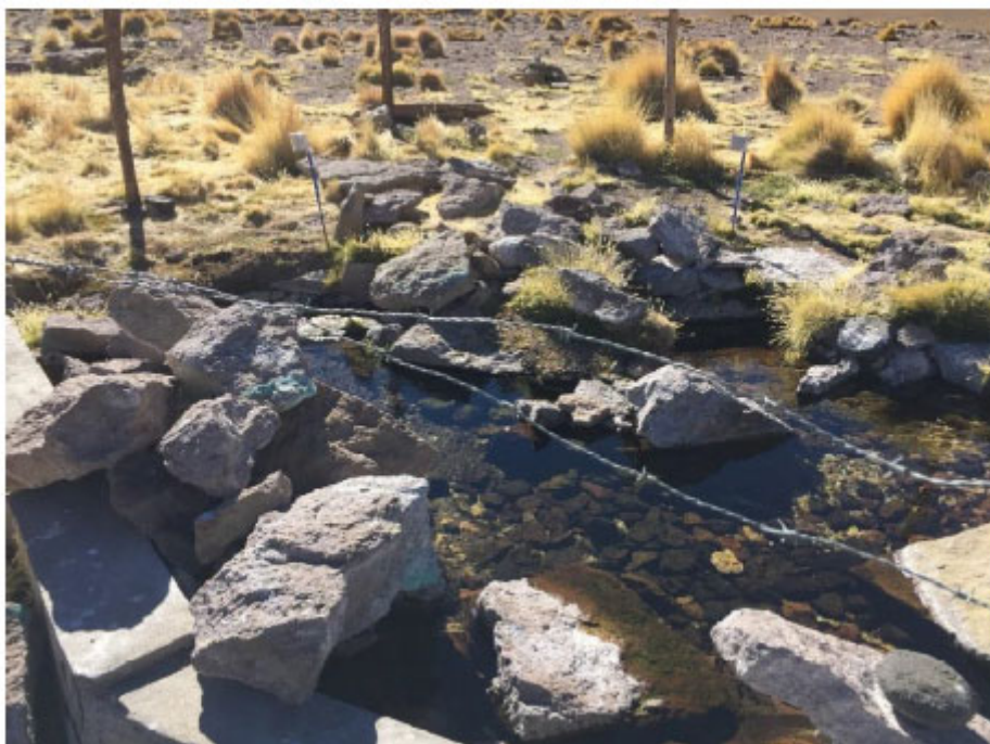
Figure 19. Pierres au bord des chenaux et systèmes de drainage, qui montrent que des explosifs ont été utilisés pour abaisser les sources et augmenter leur écoulement (source : annexe F, dans DHI, rapport final)
