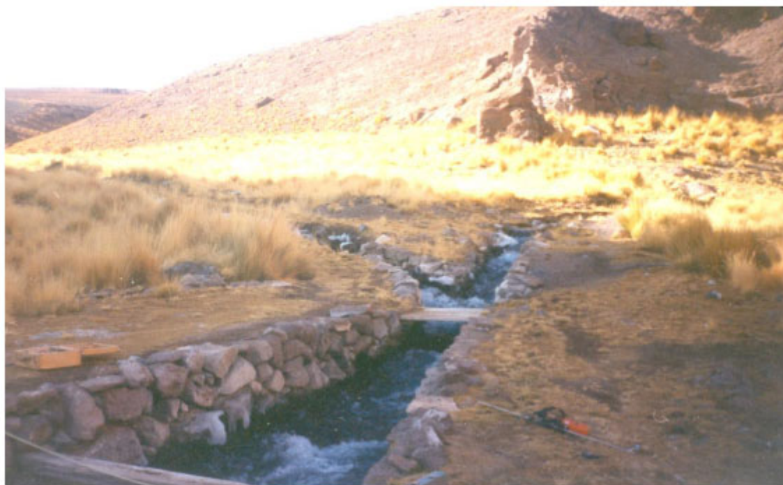
Figure 8. Ouvrage de pierres du chenal principal, à l'endroit où il reçoit l'eau acheminée par les deux chenaux principaux subsidiaires venant de la gorge nord (Cajones) et de la gorge sud (Orientales) (source : DIREMAR, 2018)
