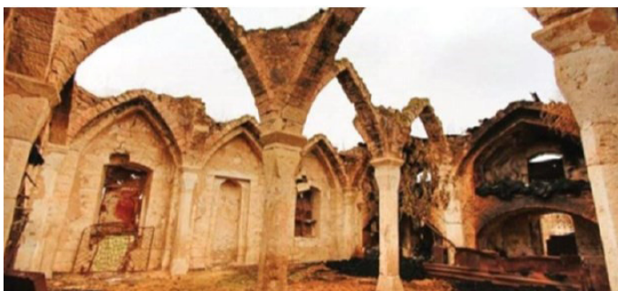
Figure 12 : Mosquée détruite dans le village de Giyasly.
