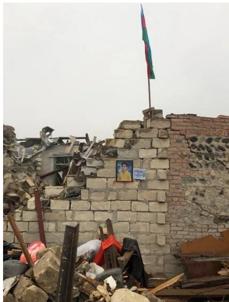
Figure 11 : Sur le mur d'une maison détruite est encore accrochée la photographie d'un enfant azerbaïdjanais tué dans les attaques du 17 octobre 2020 contre Ganja 143 .
