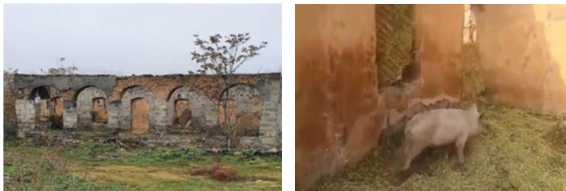
Figure 9 : La mosquée du XVIII e siècle du village de Mamar, à Gubadly, utilisée comme porcherie.
