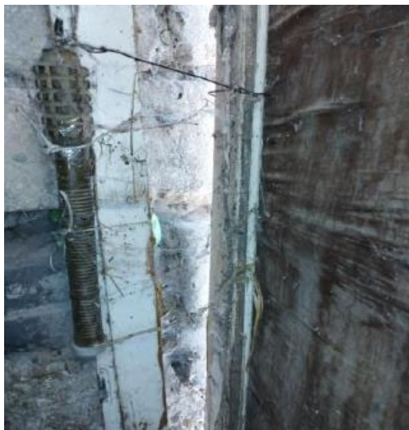
Figure 5 : Mine placée dans l'embrasure d'une porte dans le district de Latchine 41 .
